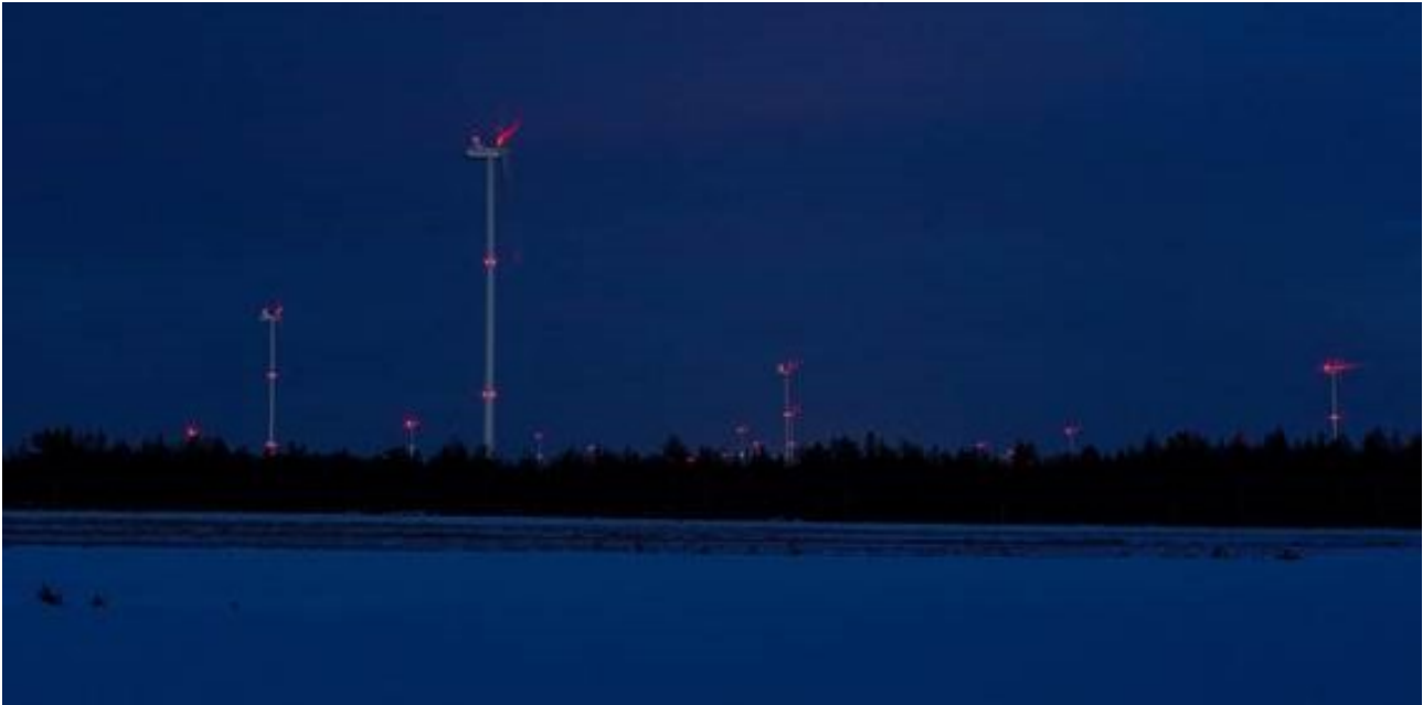
Kuva 2-3: Kiinteät punaiset lentoestevalot. (Kuva: FCG)
