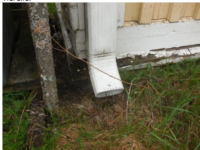
Vedet lasketaan suoraan rakennuksen vierelle.
