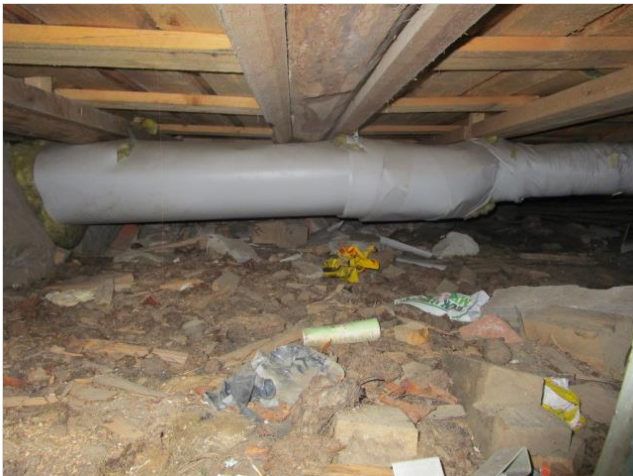
Alapohjassa vietyä talotekniikkaa.
