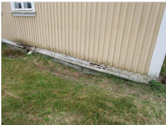
Julkisivulaudoituksen alaosa sekä alin hirsi on lahonnut useista kohtaa (nähtävästi roiskevesien vuoksi).
