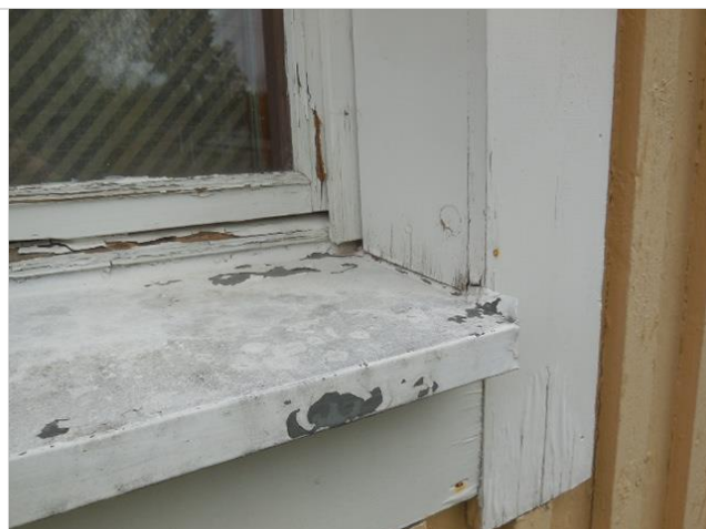
Ikkunapeltien ylösnostot on viistetty asianmukaisesti ikkunanpielilautojen väliin.
