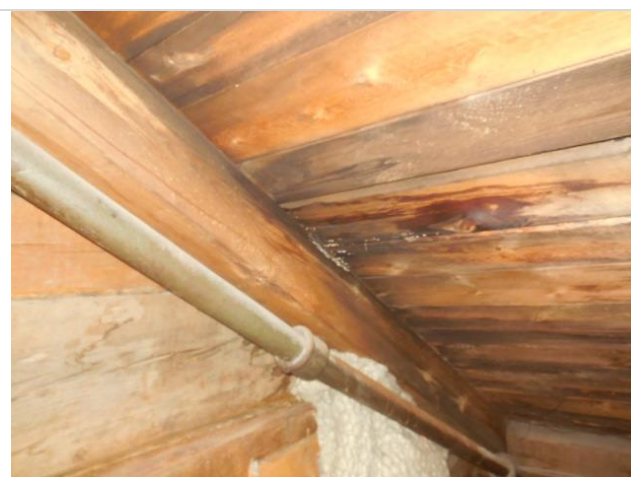
Huoneiden katon paneloinnissa ja vesikaton aluslaudoituksessa on useissa kohtaa viitteitä vuodoista (etenkin katteen läpivientien kohdat).
