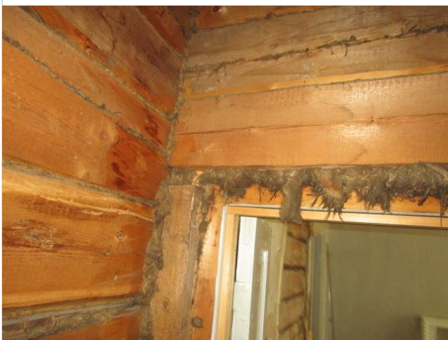
Hirsien tilkkeenä on käytetty mm. perunasäikeistä tehtyä rivettä ja pellavaa.
