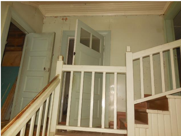
Rakennuksen ullakkotiloihin on käynti rakennuksen sisältä portaita pitkin.
