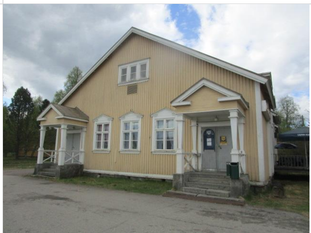
Rakennusta ympäröivä maanpinta on tasainen ja osin nurmi-, osin asfaltti- ja osin sorapinnalla.
