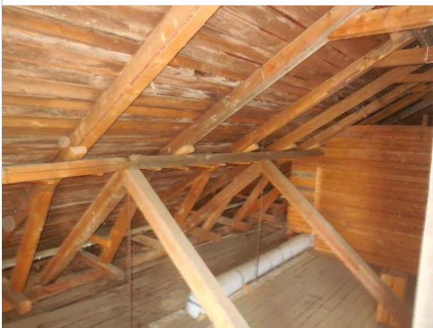
Yleiskuvia ullakon tuuletustilasta.
