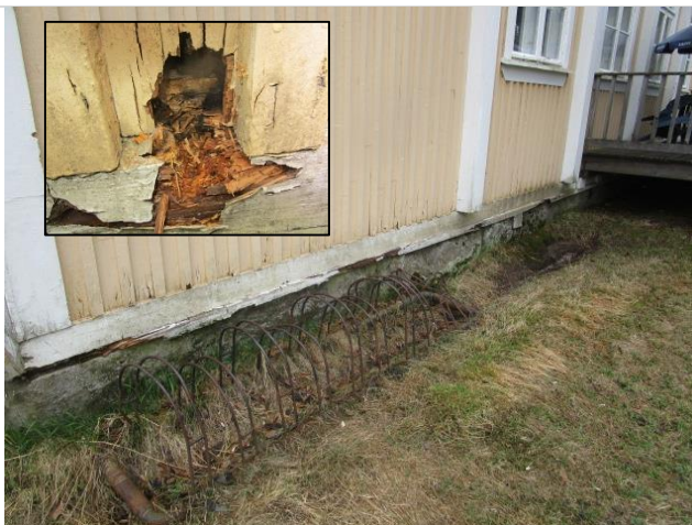
Julkisivulaudoituksen alaosa sekä alin hirsi on lahonnut useista kohtaa (nähtävästi roiskevesien vuoksi).
