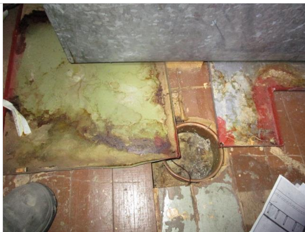
Ilmanvaihtokoneen kondenssivedet on johdettu kupariseen kuivakaivoon ilmanvaihtokoneen alla irrallaan olevien kaukaloiden kautta (epäluotettava järjestelmä).
