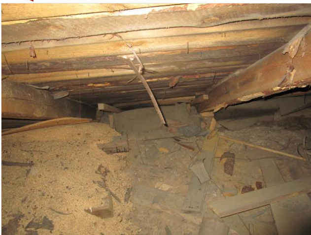
Yläpohjan tuuletus raot on pyritty järjestämään tuulenohjuslevyin.
