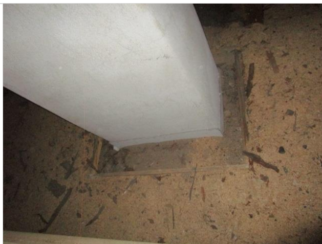
Rakennuksen yläpohjan eristeenä on mm. hiekkaa, sahanpurua ja turvetta.
