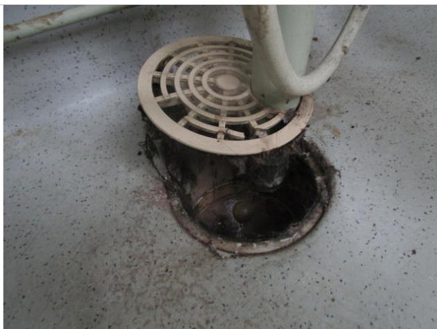
Tilan lattioissa on muovikaivot (uusittu peruskorjauksen yhteydessä).
