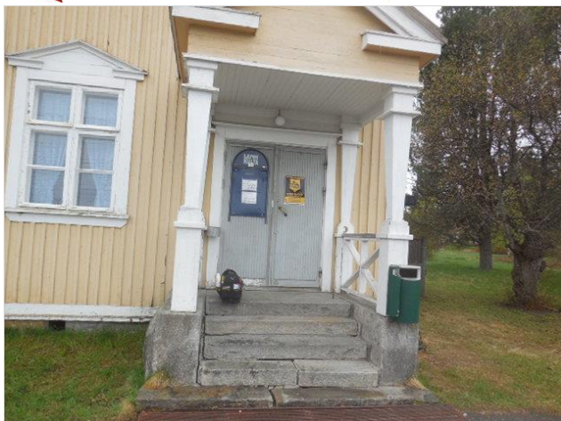
Rakennuksen ulko-ovien edessä olevat porrastasot ovat luonnonkiveä ja ne ovat katettu puurunkoisin katoksin.
