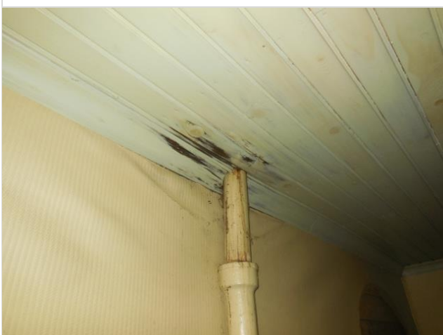
Huoneiden katon paneloinnissa ja vesikaton aluslaudoituksessa on useissa kohtaa viitteitä vuodoista (etenkin katteen läpivientien kohdat).
