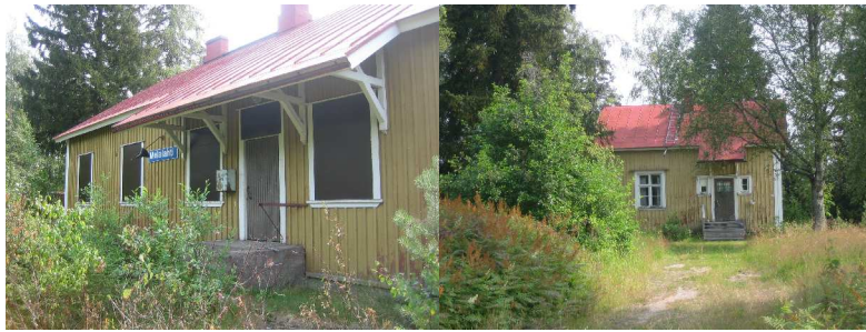
+ kaunis rakennuspari; rautatieasema (rak.vuosi 1930) ja radanvartijan asunto - rakennukset tyhjiillään
