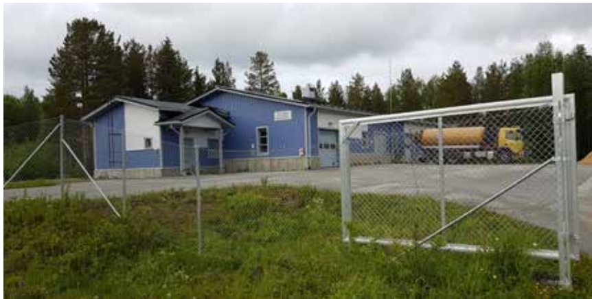
Kylänpurontien päässä sijaitseva Paltamon jätevedenpuhdistamo.
